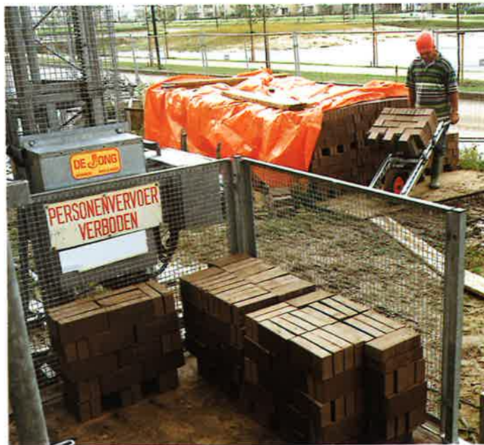
Opkar zet 6e hap stenen in de tandheugellift
